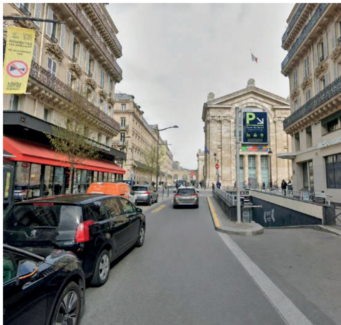
Rue de Compiègne: accès au parking sous-terrain de la gare du Nord
